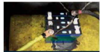
Prova di cortocircuito
